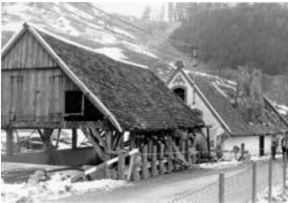
Fahrngruber-Hammer: Generalsanierung von Kohlbarren, Hackenschmiede und Magazin
