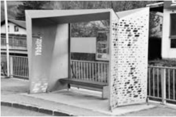
Buswartehaus - Metallgestaltung unter zu Hilfenahme neuer Materialien und Bearbeitungstechniken
