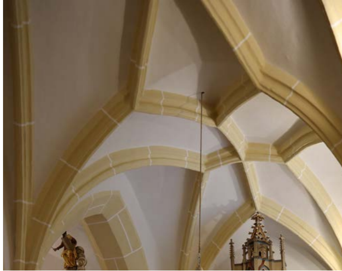
Gotisches Kreuzrippengewölbe: Errichtung des Südtraktes erfolgte im 15. Jahrhundert.
