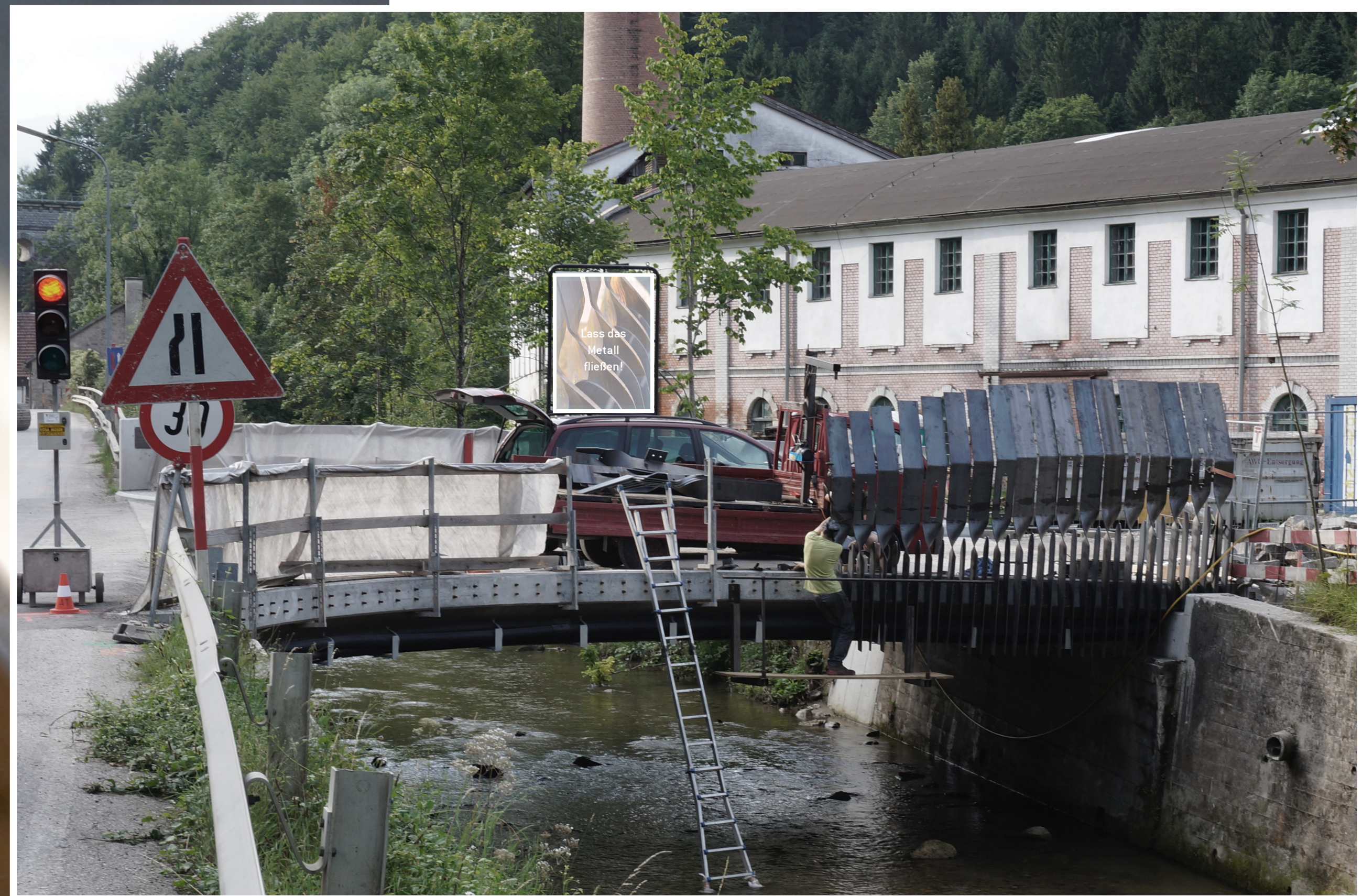
Under construction: Die Westseite wird montiert.
