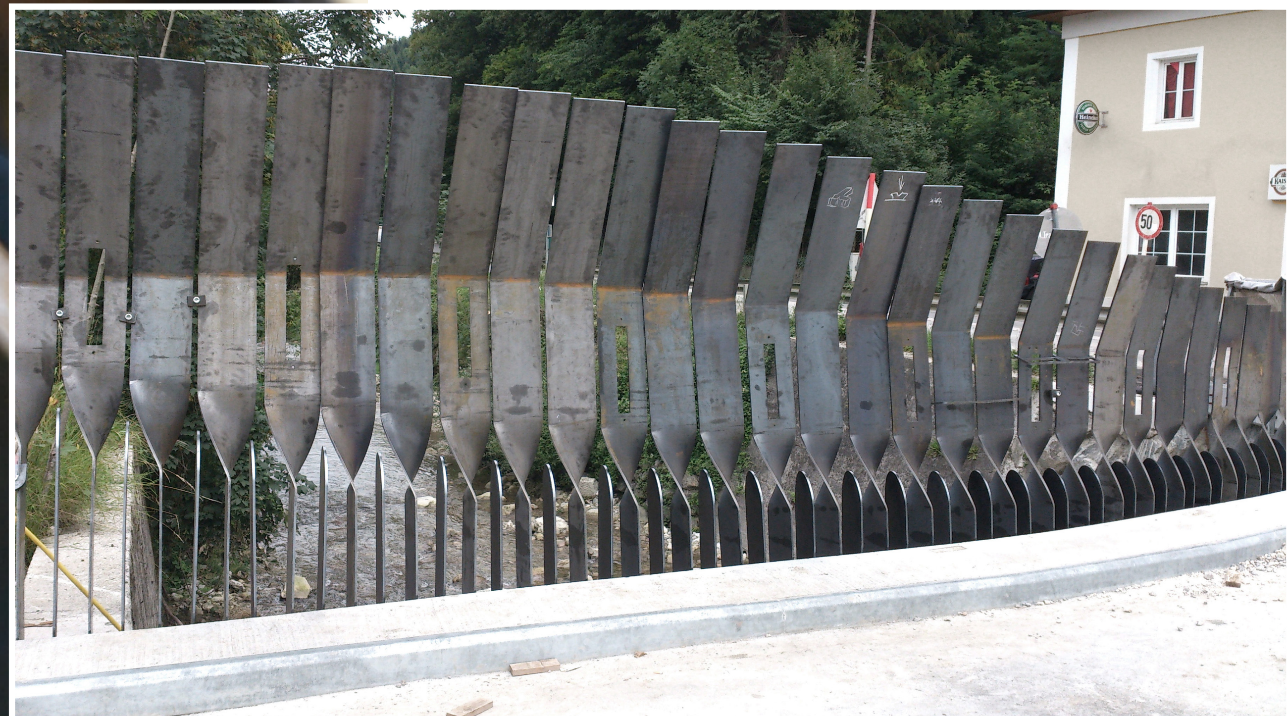
Die montierte Westseite von innen: die Schraubklammern werden ersetzt durch schmiedehandwerkliche Nieten, im Bereich der Langlöcher wird schmiedehandwerklich ausgeklappt. Das Handwerk erfüllt die letzte Bautoleranz.
